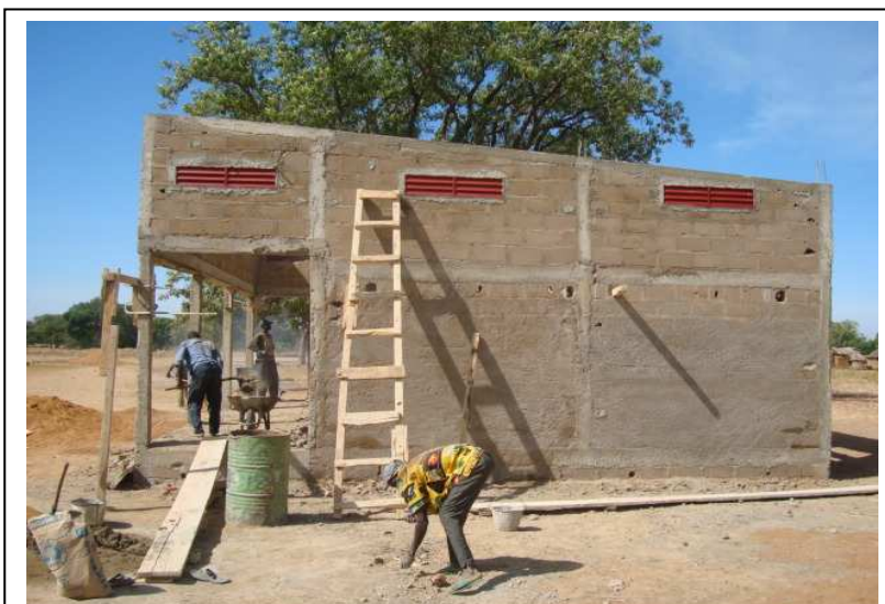
Le chantier aujourd'hui 4 Décembre 2009
